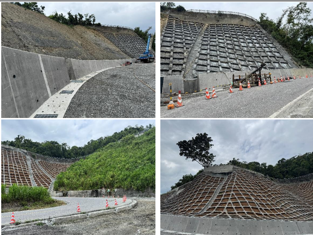
工區 A~D 工程現況
