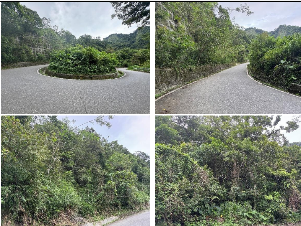
工區 K、L 工程現況
