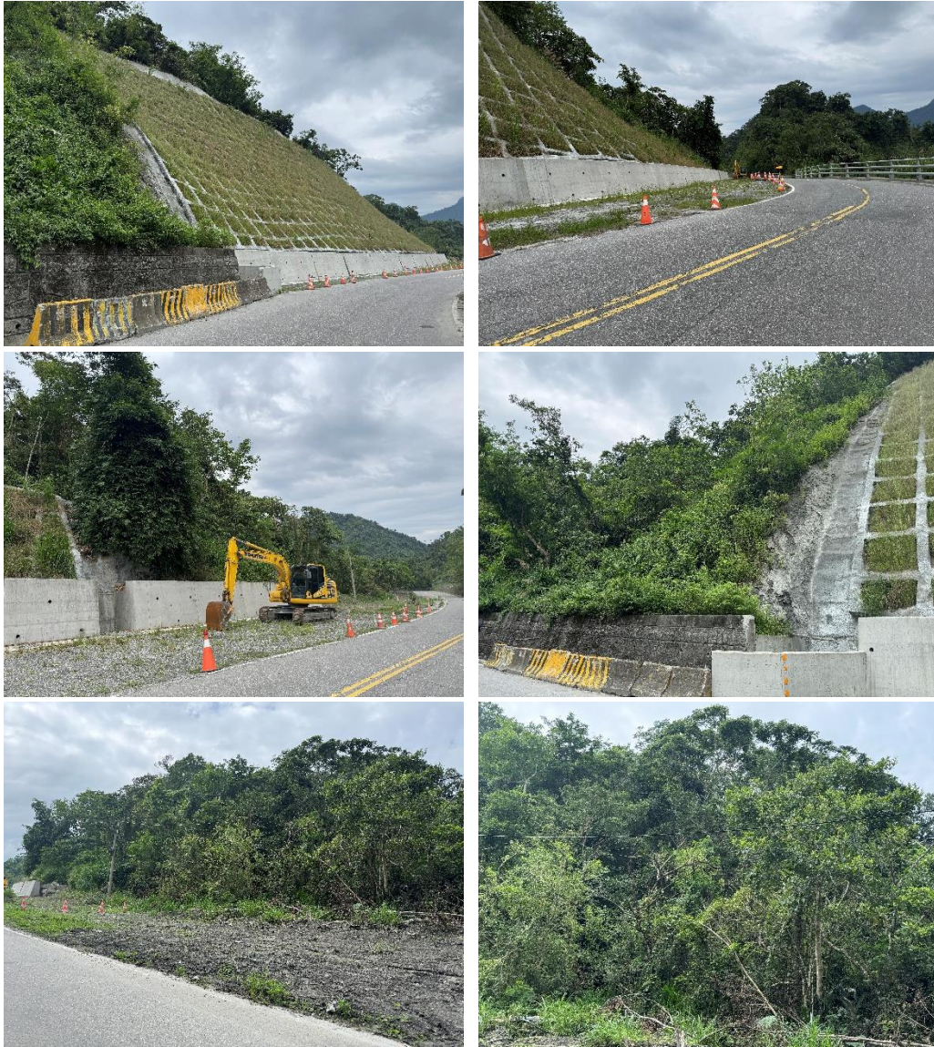
工區 E、F 工程現況
