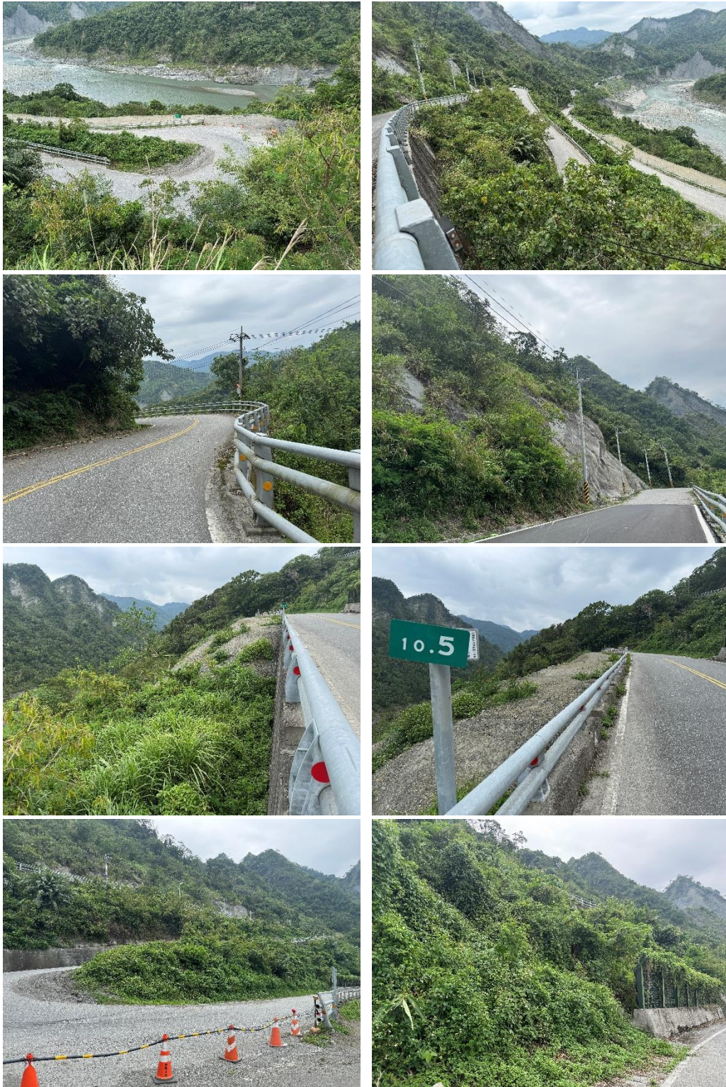
工區 H 工程現況
