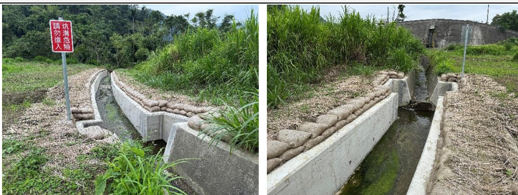
工區 M 工程現況
