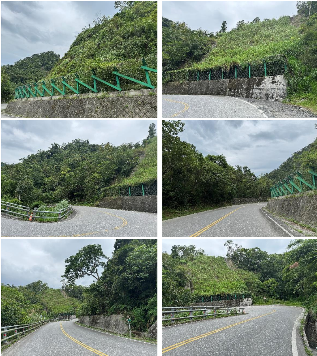
工區 G 工程現況
