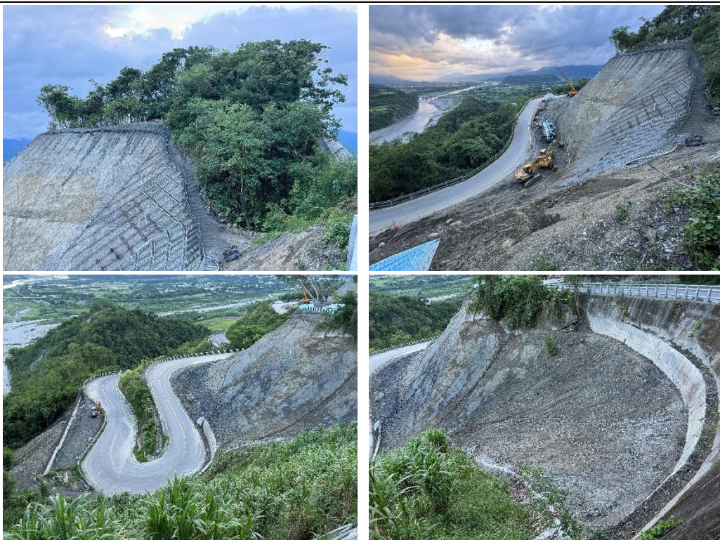
工區 A~D 工程現況
