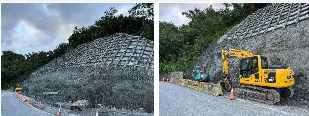
工區 E、F 工程現況
