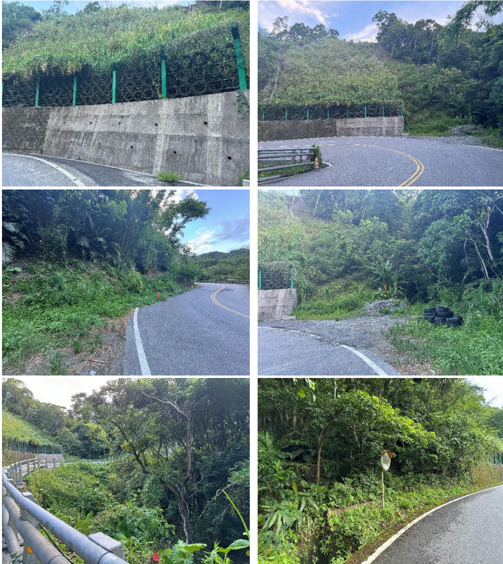
工區 G 工程現況
