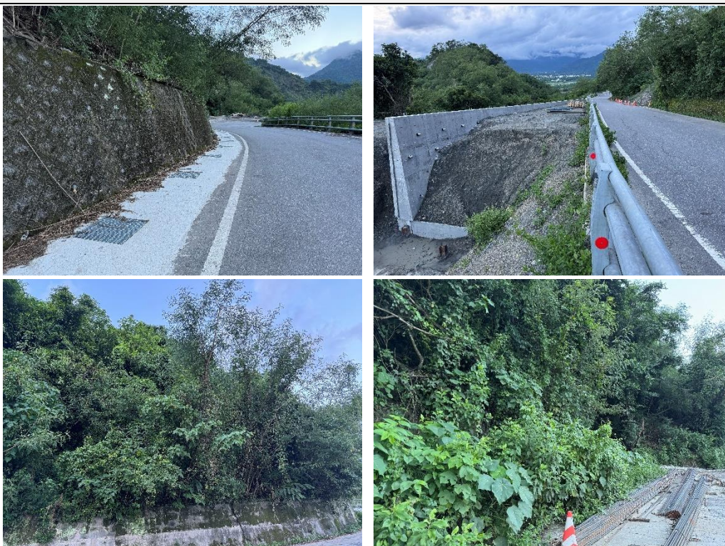
工區 A~D 工程現況
